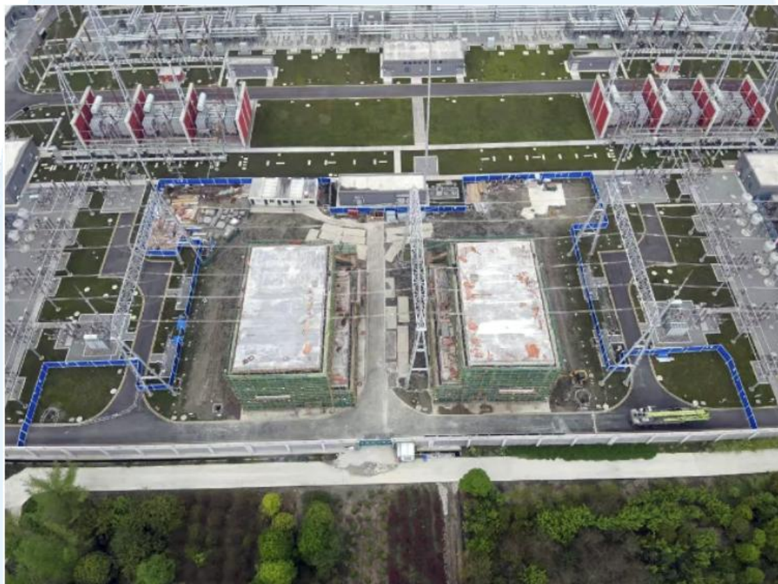
国网四川成都供电公司500kV玉堤变电站66kV动态无功补偿新增工程SVG室主体结构
