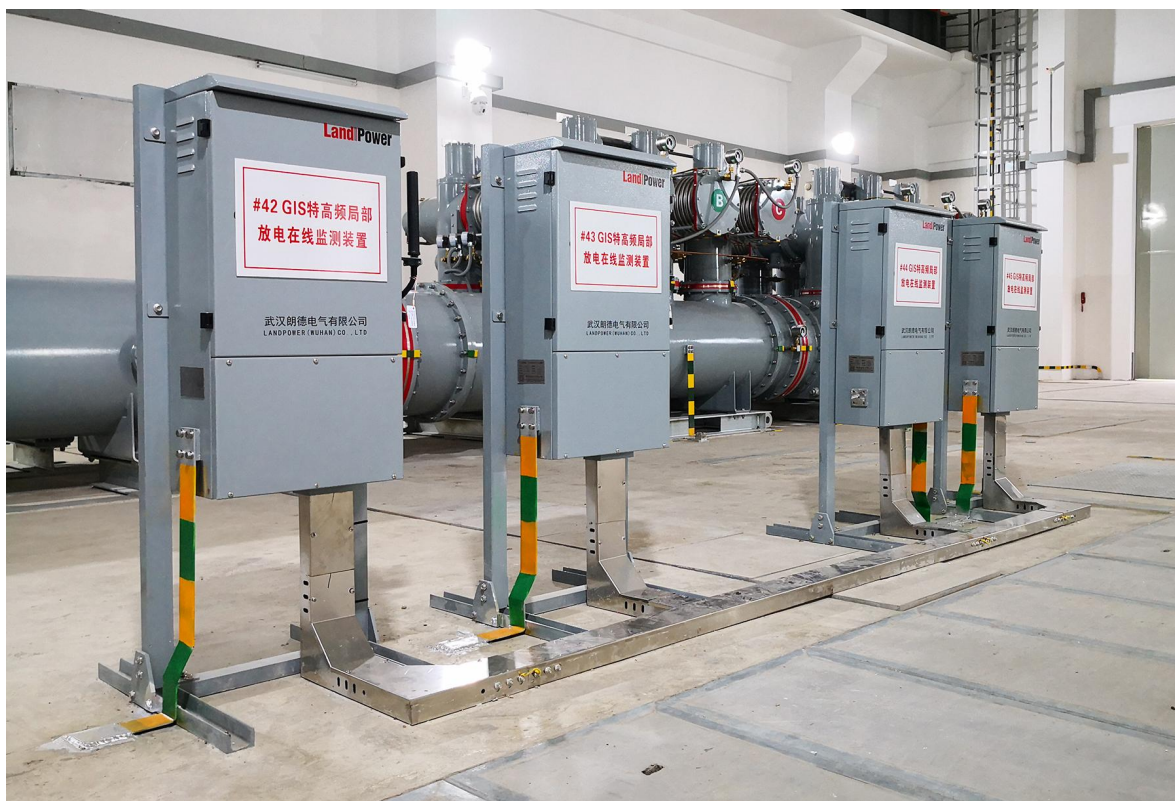
张家口市220kV古杨树变电站-朗德电气GIS高频局部放电在线监测装置
