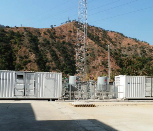
成都铁路局电气化铁路SVC装置图
